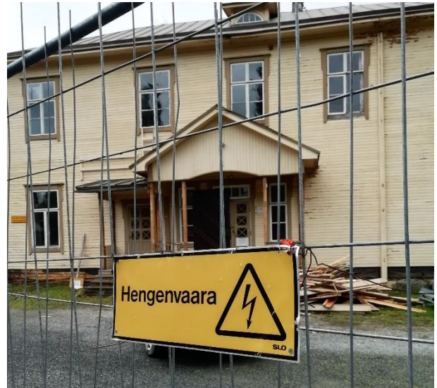
Työmaa-alue suojattiin asianmukaisesti rakenteiden korjauksen aikana.
