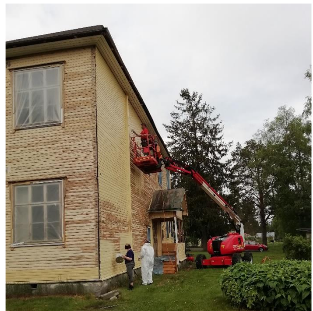
Maalauksessa huomioitiin tarvittavat koulutukset ja luvat mm. kurottajan käyttöön. Maaliruiskun käyttö joudutti työtä.
